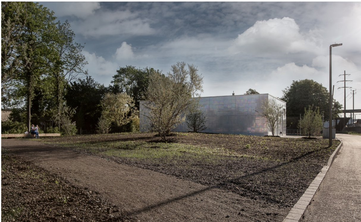
Abbildung 1: Regenbecken Talacker, Fassade Betriebsgebäude
